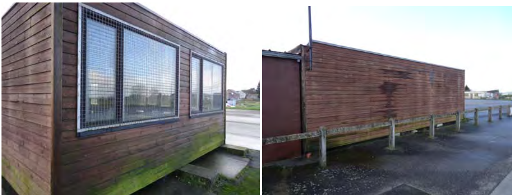
Vue sur l'un des bâtiments en place © S&A - 2011
