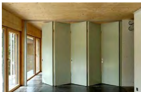
Exemple de cloisons amovibles permettant de moduler l'espace
