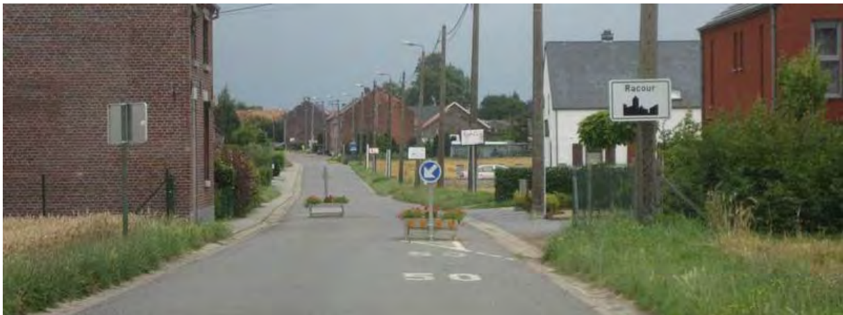
Exemple de rétrécissement de voirie – « Effet de porte »
